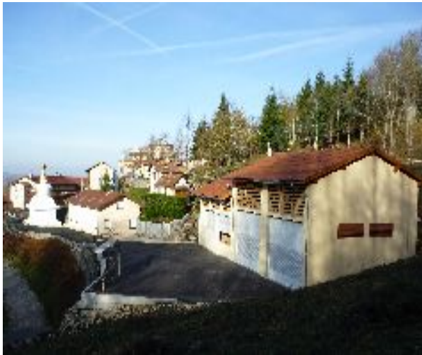
Vue de la chaufferie et du Centre de Montchardon
