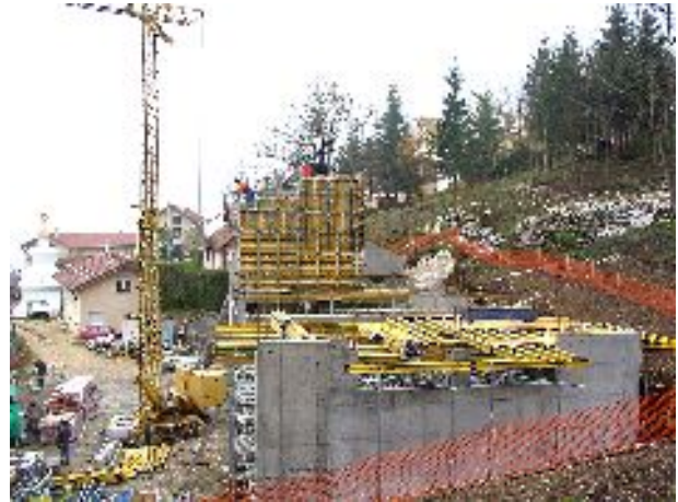
Construction du bâtiment - novembre 2008
